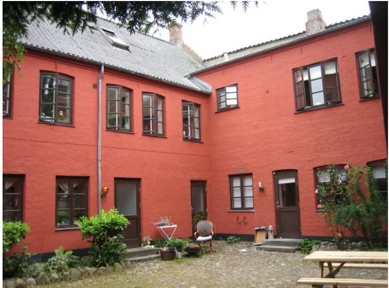
Storegade 17 sidebygning og baghus
